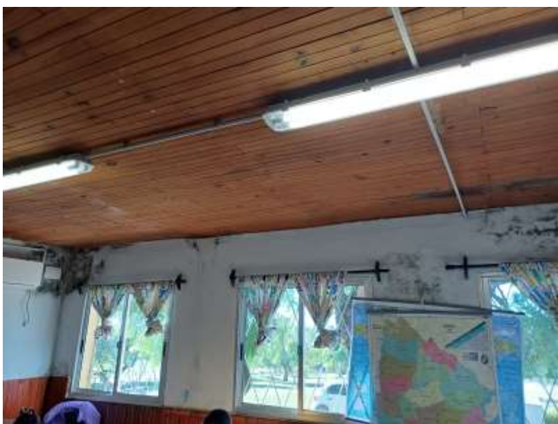
Salón al frente, filtraciones de techo y humedad en paredes
